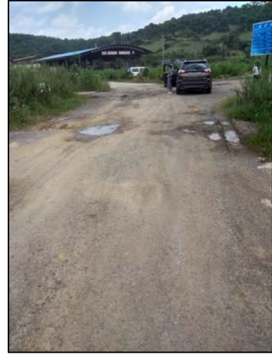
照片 1-2 已建矿山道路
