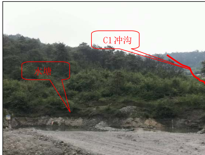
照片 2-6 C1 冲沟
